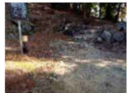
美濃金山城二の丸虎口部分破却跡
