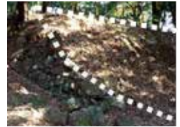
美濃金山城二の丸虎口部分破却跡
